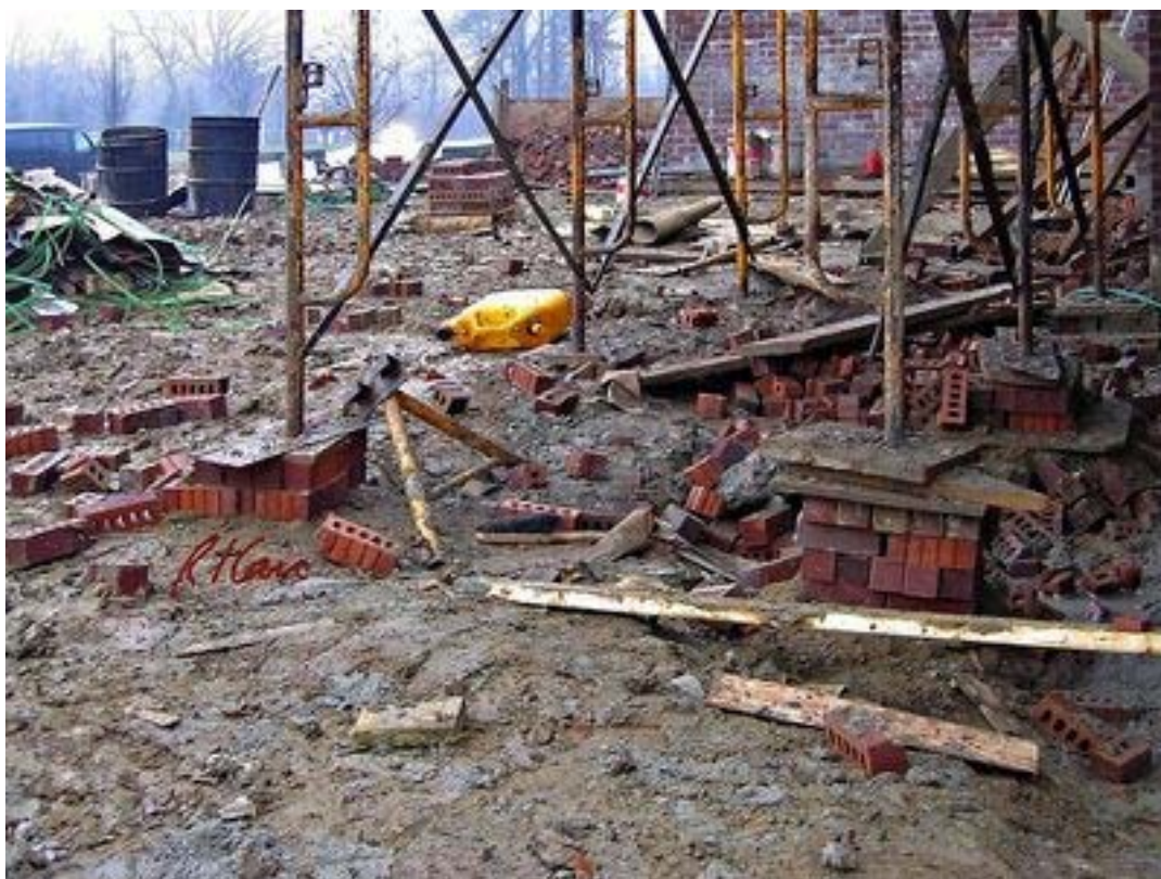
رفتار نا ایمن در نصب پایه های داربست
