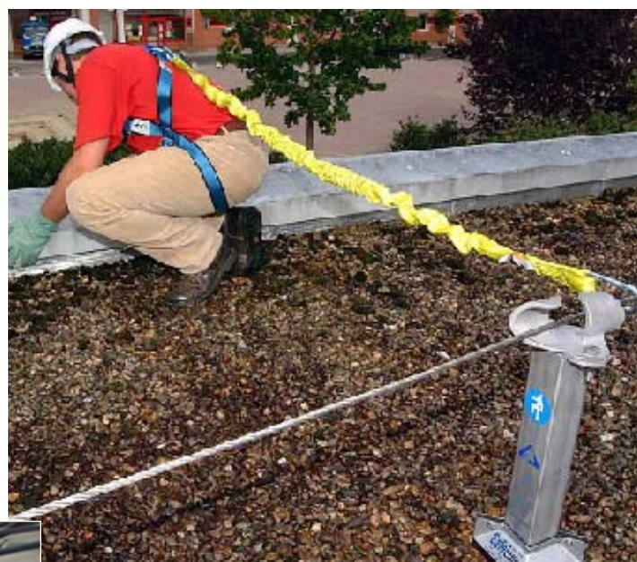
شکل ۵۴-۲- محدود کننده با اتصال یک طناب
